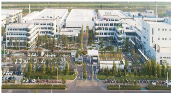
图 27: 河南生产基地实景: 252 亩智能制造产业园, 130000 平方米全自动化生产车间
